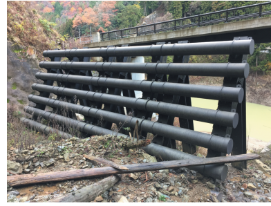
写真2 施工例（兵庫県）
