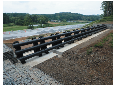
写真3 施工例（福島県）
